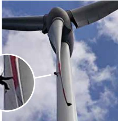
Unabhängige Gutachter kontrollierten die Rotorblätter auf Schäden durch Blitzeinschläge.
