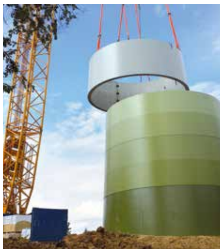
Der Turm wird mit einem Spezialkran aufgebaut: Unten aus Betonringen, darauf folgen Stahlringe bis zur Nabenhöhe von 135 m.
