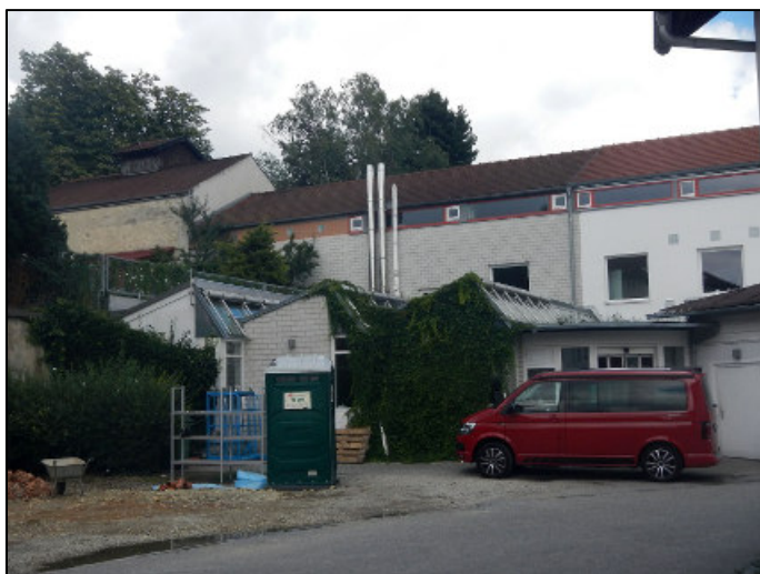
Abbildung 8: Kamine an der Westfassade (Bäckerei)
