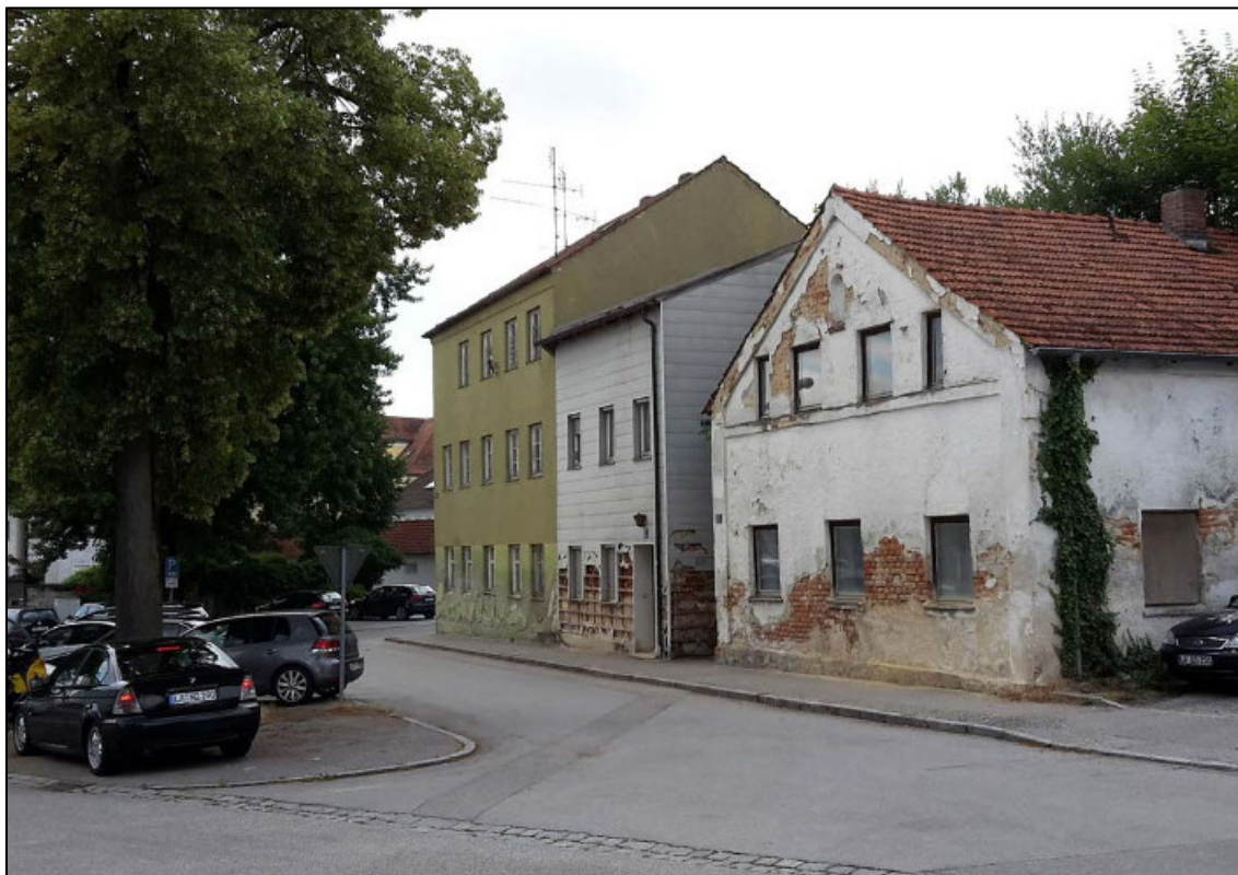
Abbildung 4: Auffällige Gebäude im Plangebiet, die abgebrochen werden sollen
