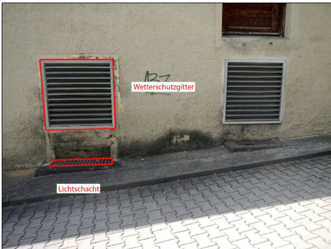
Abbildung 17: Lichtschacht und Wetterschutzgitter in der Ostfassade des Bestandgebäudes
