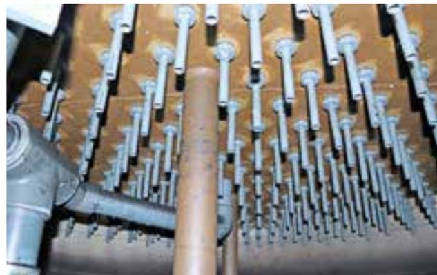
Das Filtermaterial in den fünf Stahlfiltern zur Reinigung des Beckenwassers wurde ausgetauscht. Rechts: Auch die Filterkerzen als letzte Reinigungsstufe des Beckenwassers wurden erneuert.
