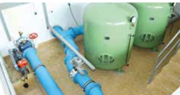
Die Brunnenpumpen der Stadtwerke werden zu über 80 Prozent mit Strom aus der nahegelegnen PV-Anlage betrieben.
