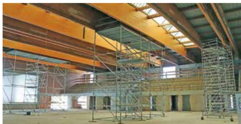
Am Tragsystem der Halle sind keine größeren Veränderungen vorgesehen. Die bestehenden Holzbinder sollen erhalten und zum besseren Schutz der Bauteile innerhalb der wärmegeämmten Gebäudehülle untergebracht werden. Die Dachfläche wird erst im Frühjahr 2024 abgenommen, um den Betrieb der Arbeiten in der Halle über den Winter zu ermöglichen.
