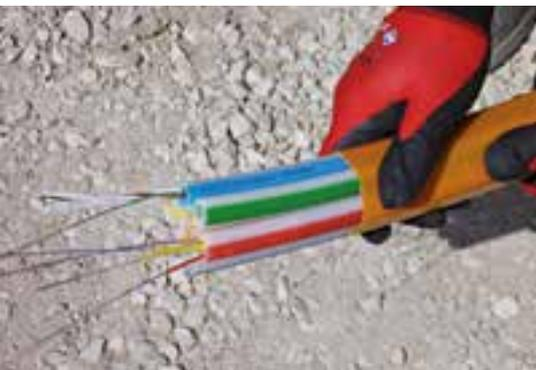
Die empfindlichen Glasfaserleitungen werden in Mikrorohrverbänden eingeblasen
