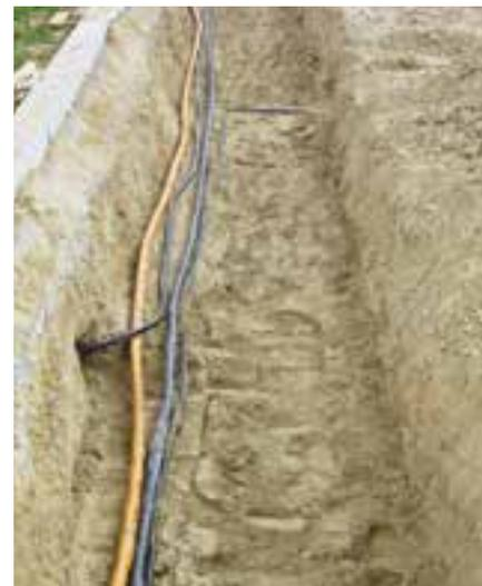
Glasfaserverlegung im Baugebiet Burger Feld: in der orangenen Leitung wird der Mikrorohrverband bis zum Endkunden geführt
